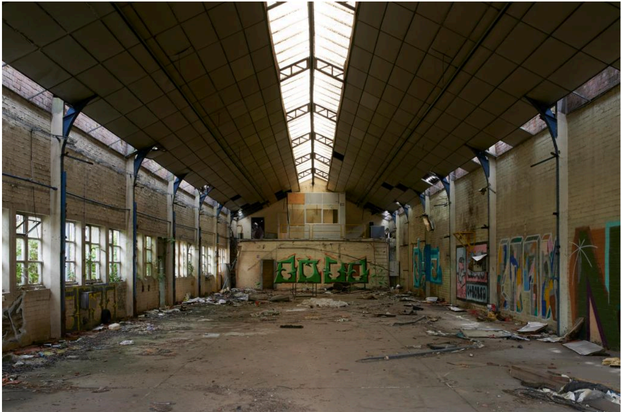
Vue intérieure du magasin sud.
