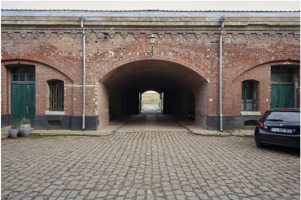
Passage couvert sous la caserne de gorge depuis la cour centrale, vers le nord.
