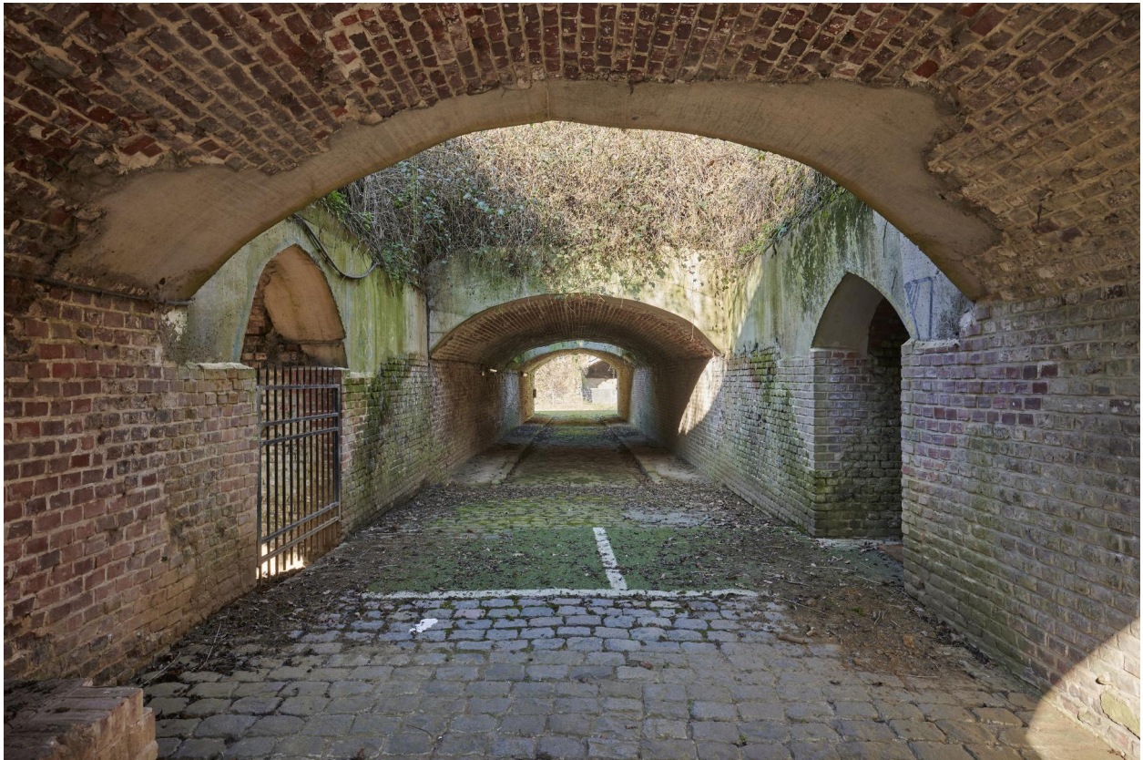
Passage couvert menant à la cour centrale.
