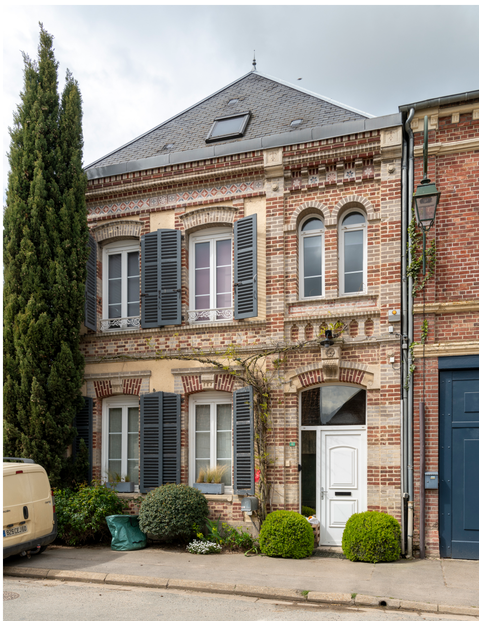
Demeure, n°8 de la rue de la Mairie, vue depuis l'est.
