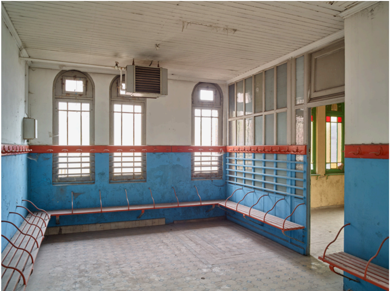
Aile nord, premier étage. Ancienne hydrothérapie des bains de luxe pour hommes, réaménagée en vestiaire collectif. Vue vers le nord, détail de l'entrée.
