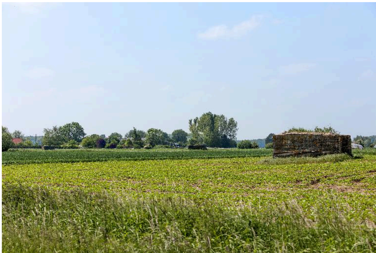
Vue générale, vers le sud-ouest
