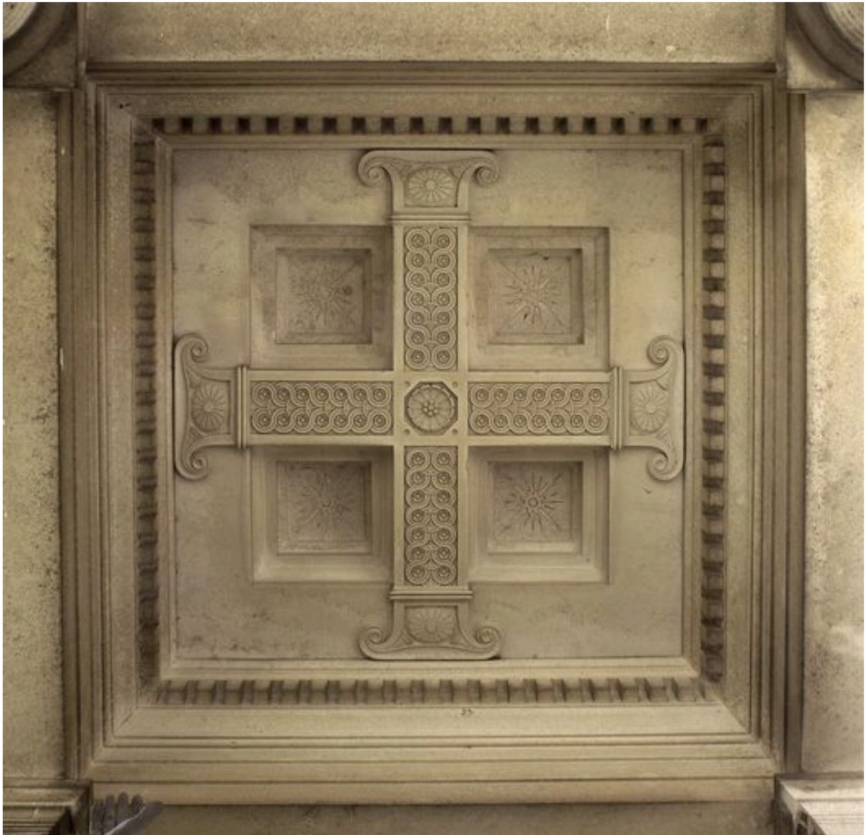
Vue du plafond à caissons.
