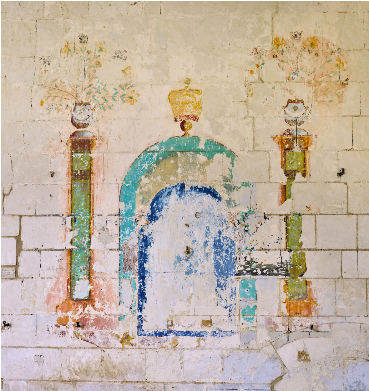
Intérieur, détail de la peinture murale, à droite de la baie 2.
