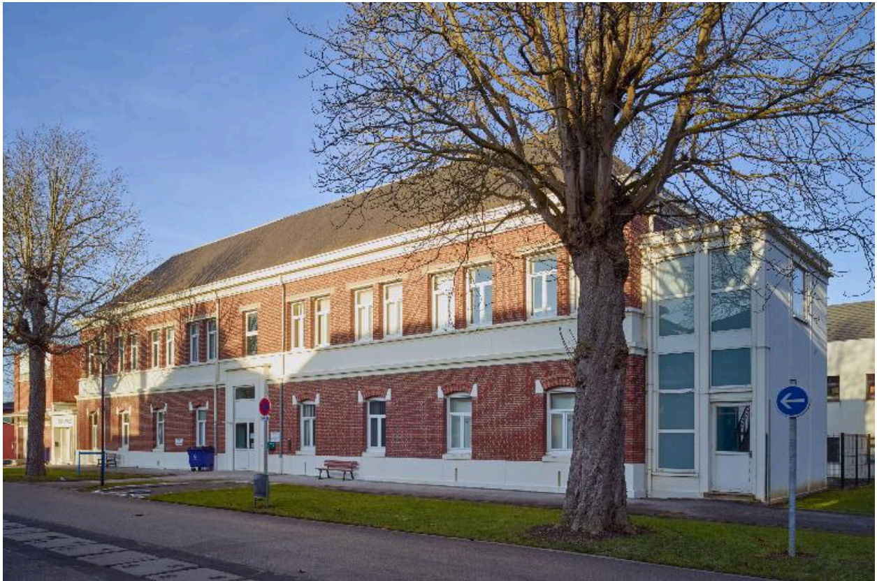
Bâtiment d'hospitalisation dit pavillon 4, élévation antérieure, vue générale prise de trois quarts droit.
