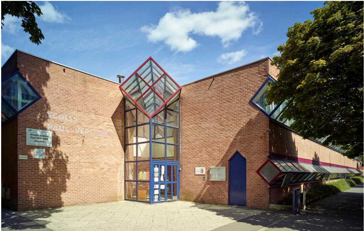
L'entrée et la façade sur la rue Vermeer.
