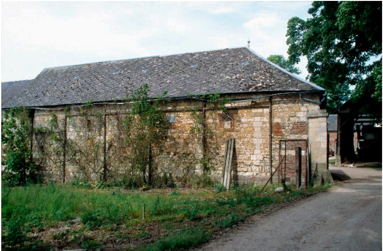
Ferme du château. Les écuries à l'entrée : élévation sur rue.
