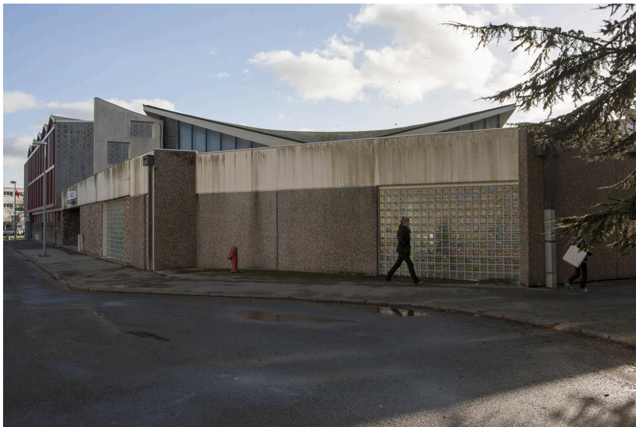
Vue de l'extension nord-ouest.
