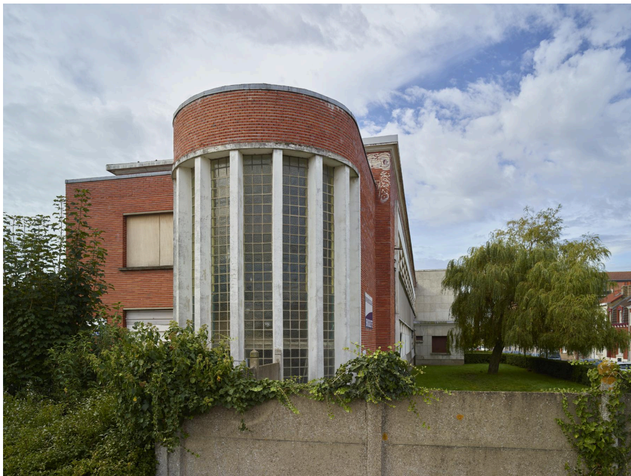
Cage d'escalier depuis la rue du Docteur Zamenhof, vers l'ouest.
