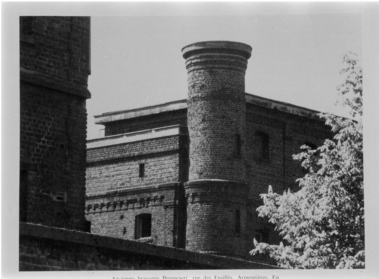
Ancienne brasserie Breuwaert, rue des Fusillés, Armentières. En
