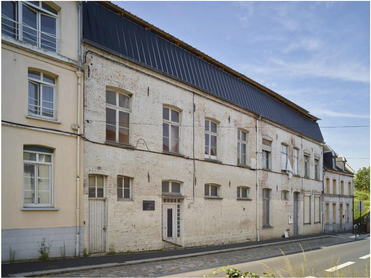
Ancienne école Sainte-Thérèse, aujourd'hui désaffectée - 35-37, rue de la Nouvelle-Zélande : façade avant.
