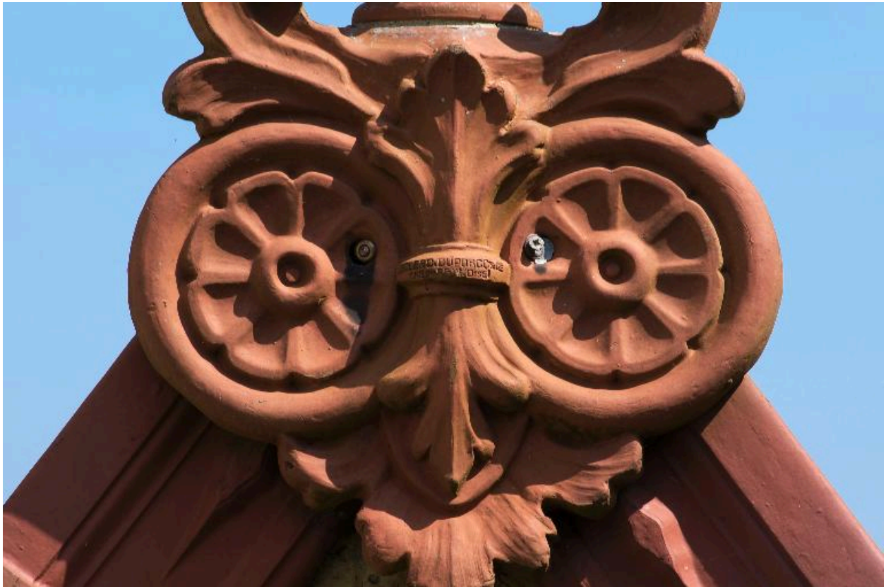
Latrine extérieure, détail de l'acrotere portant le nom de la fabrique de céramique Leclercq-Duporcq & Cie à Ons-en-Bray (Oise).
