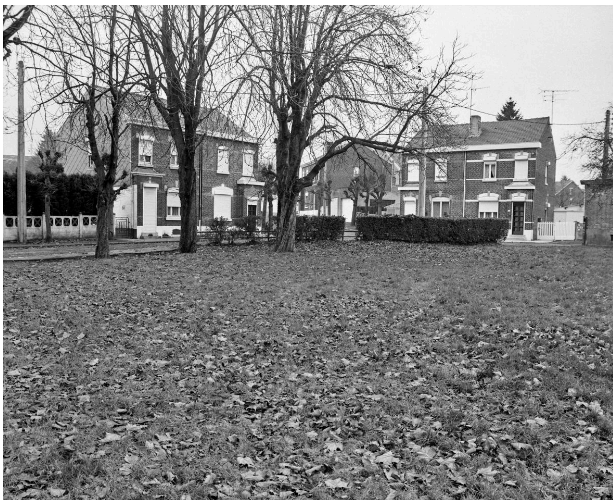
Cité de la centrale électrique de Maubeuge.
