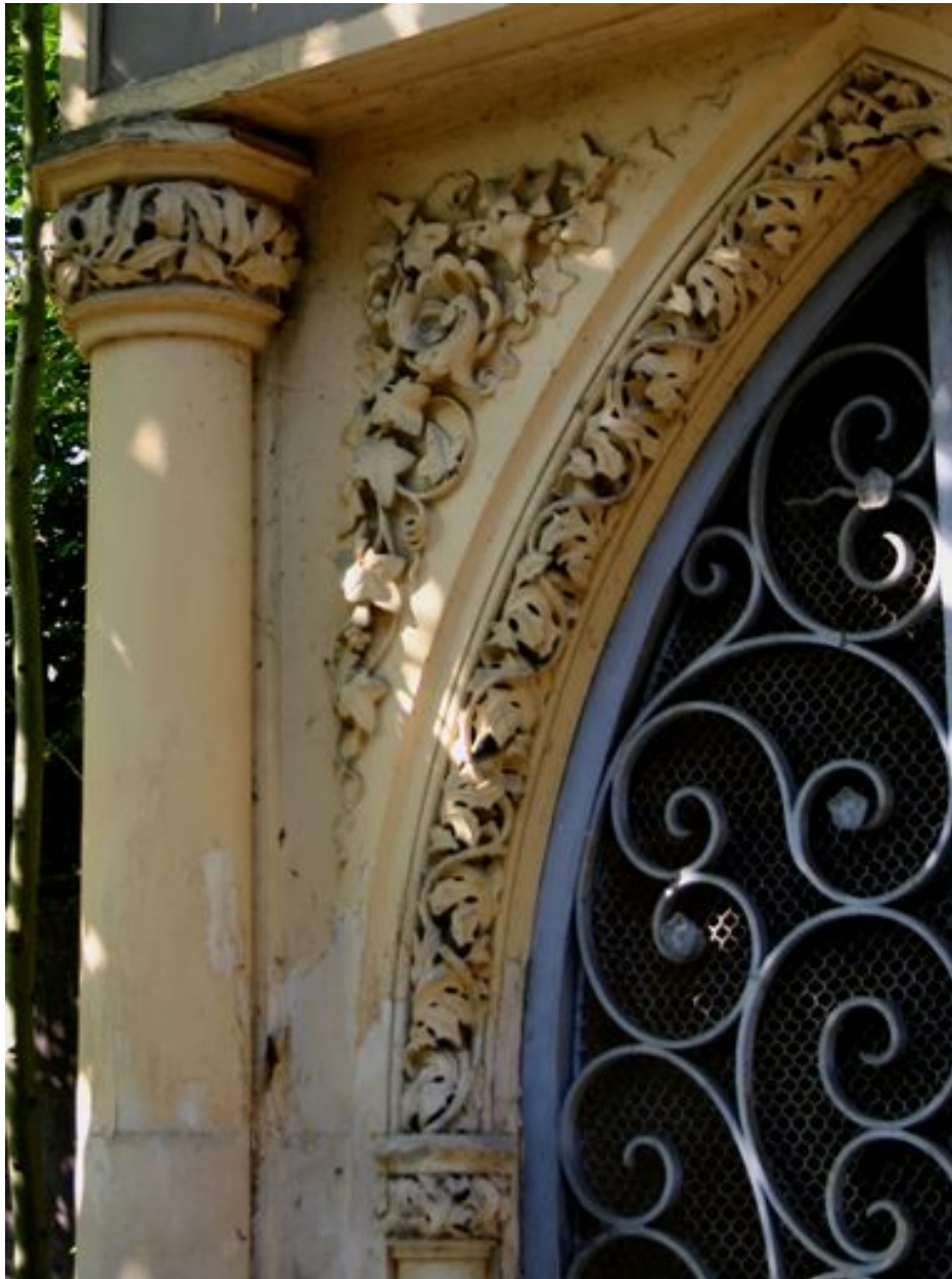
Façade principale du tombeau-chapelle : écoinçon gauche orné d'un décor sculpté de feuilles de lierre.
