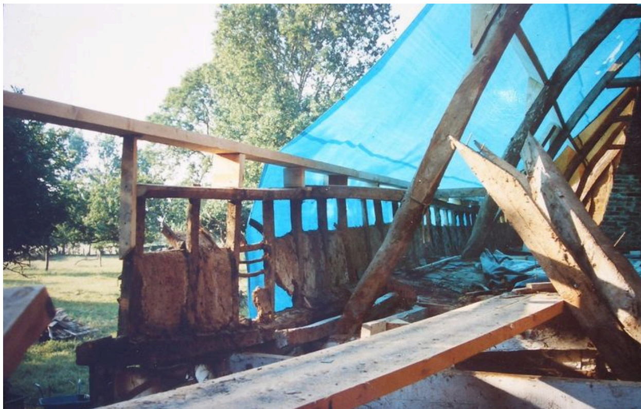
Vue de la charpente du logis.
