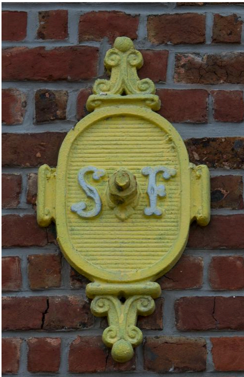
Fer d'ancrage du bâtiment subsistant en fond de parcelle.
