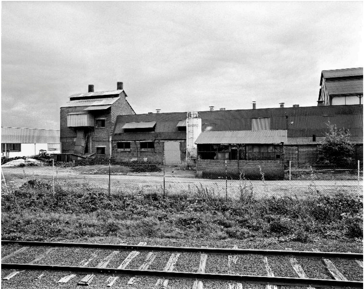
Vue partielle du site depuis le nord, en 1988.
