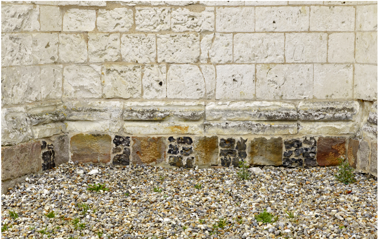
Détail du soubassement du chœur, élévation sud.
