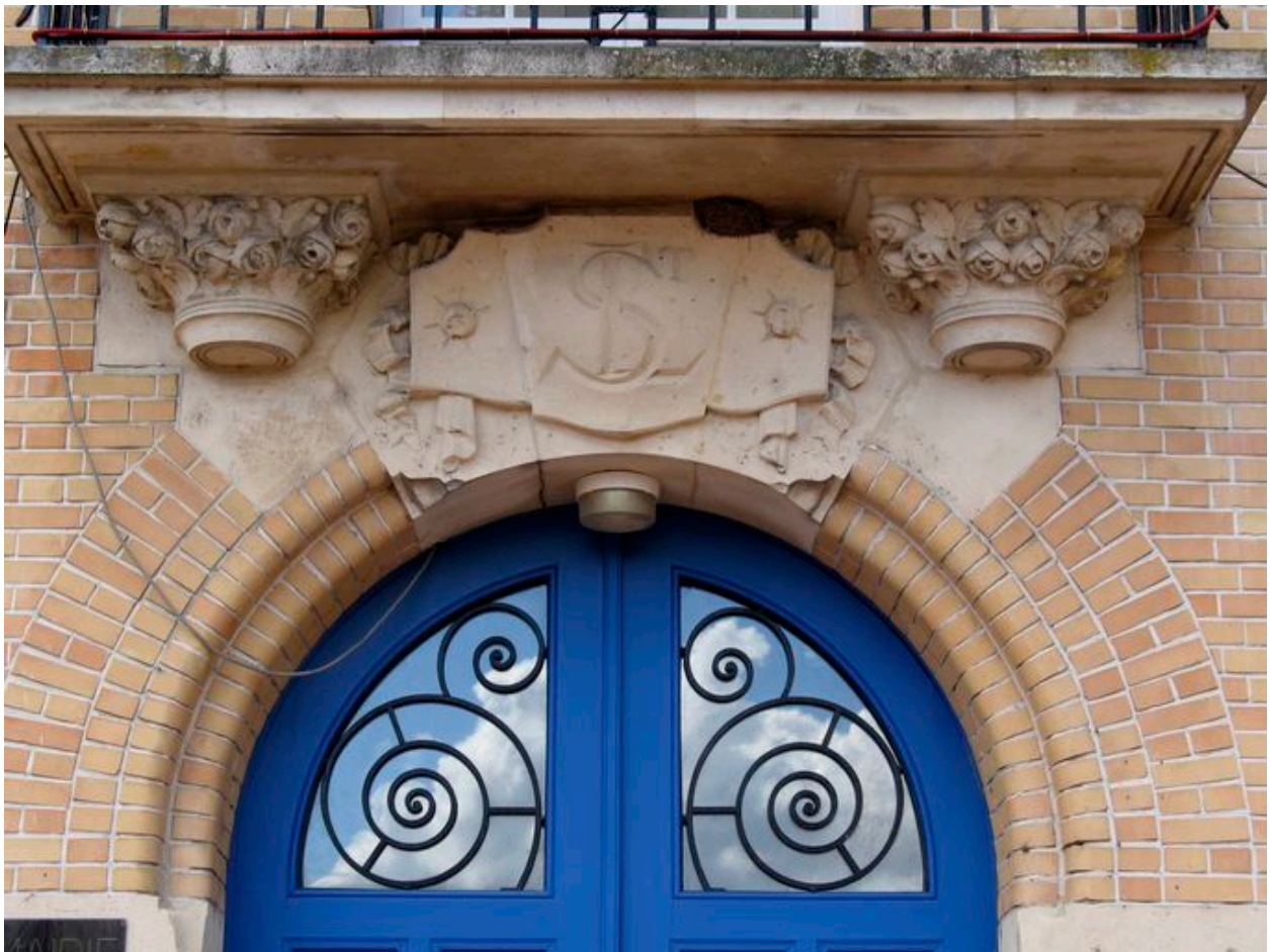
Détail des consoles de balcon et du cartouche en agrafe de l'entrée portant les initiales entrelacées St L.
