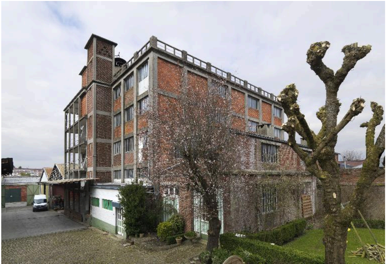
Vue d'ensemble de trois quarts de la brasserie.
