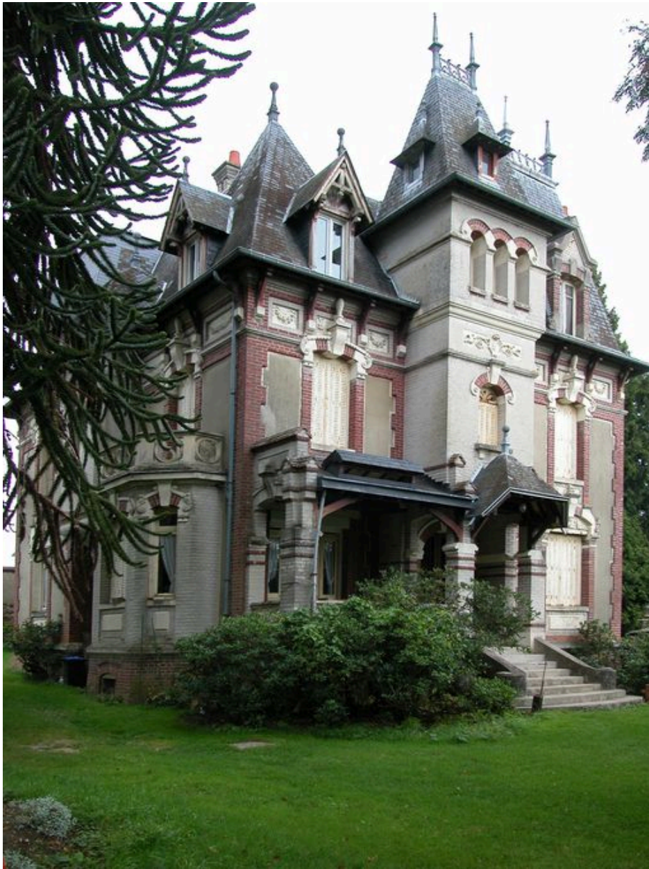
Le logement patronal, vue d'ensemble de trois-quart.
