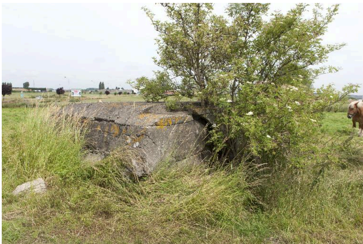
Casemate b, vue de trois-quarts vers le nord-ouest.
