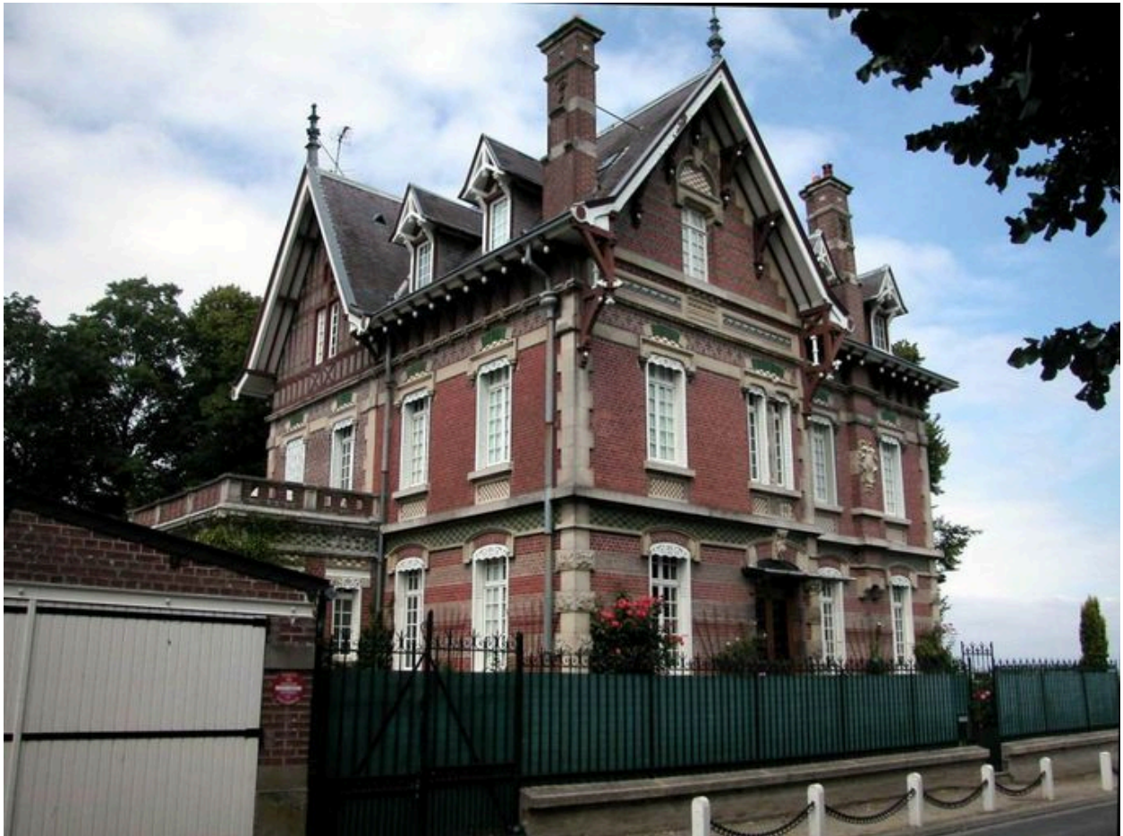
Vue de trois-quarts sur les façades postérieure et d'entrée.
