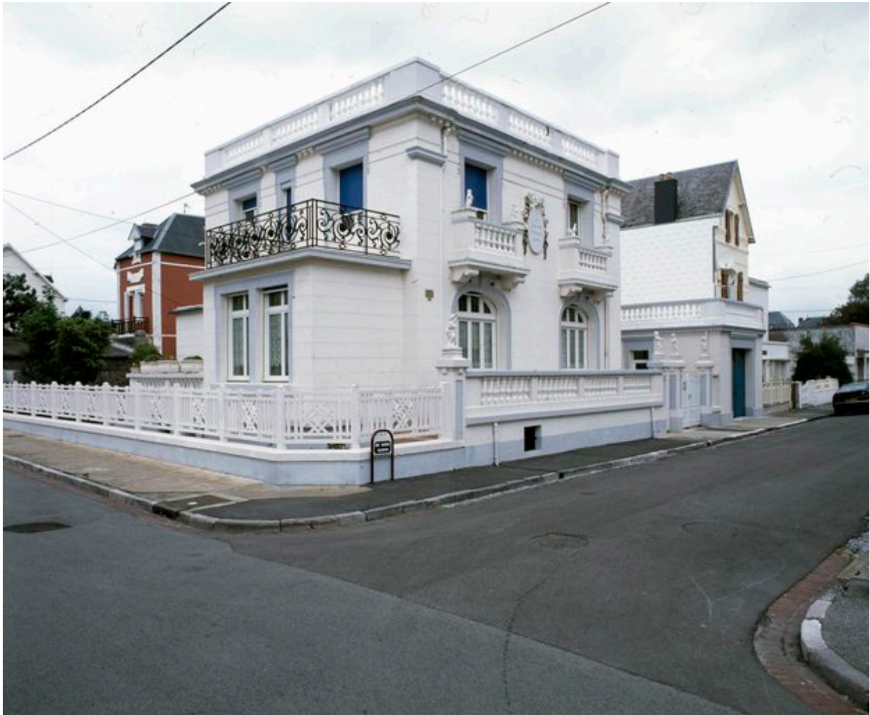
Vue générale de trois quarts, les façades sud et est.
