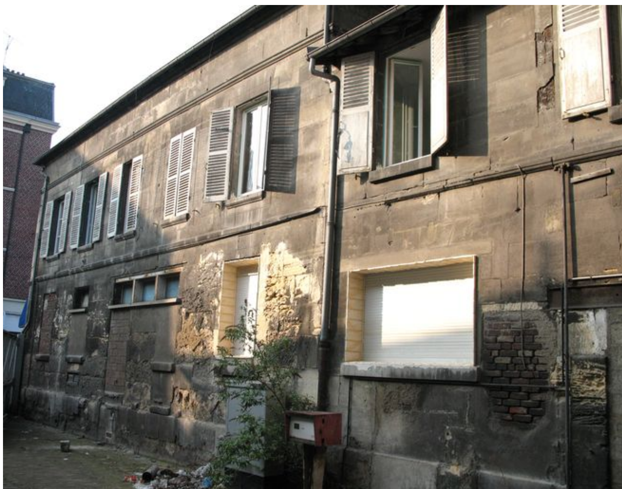
Vue des logements construits face aux bureaux.
