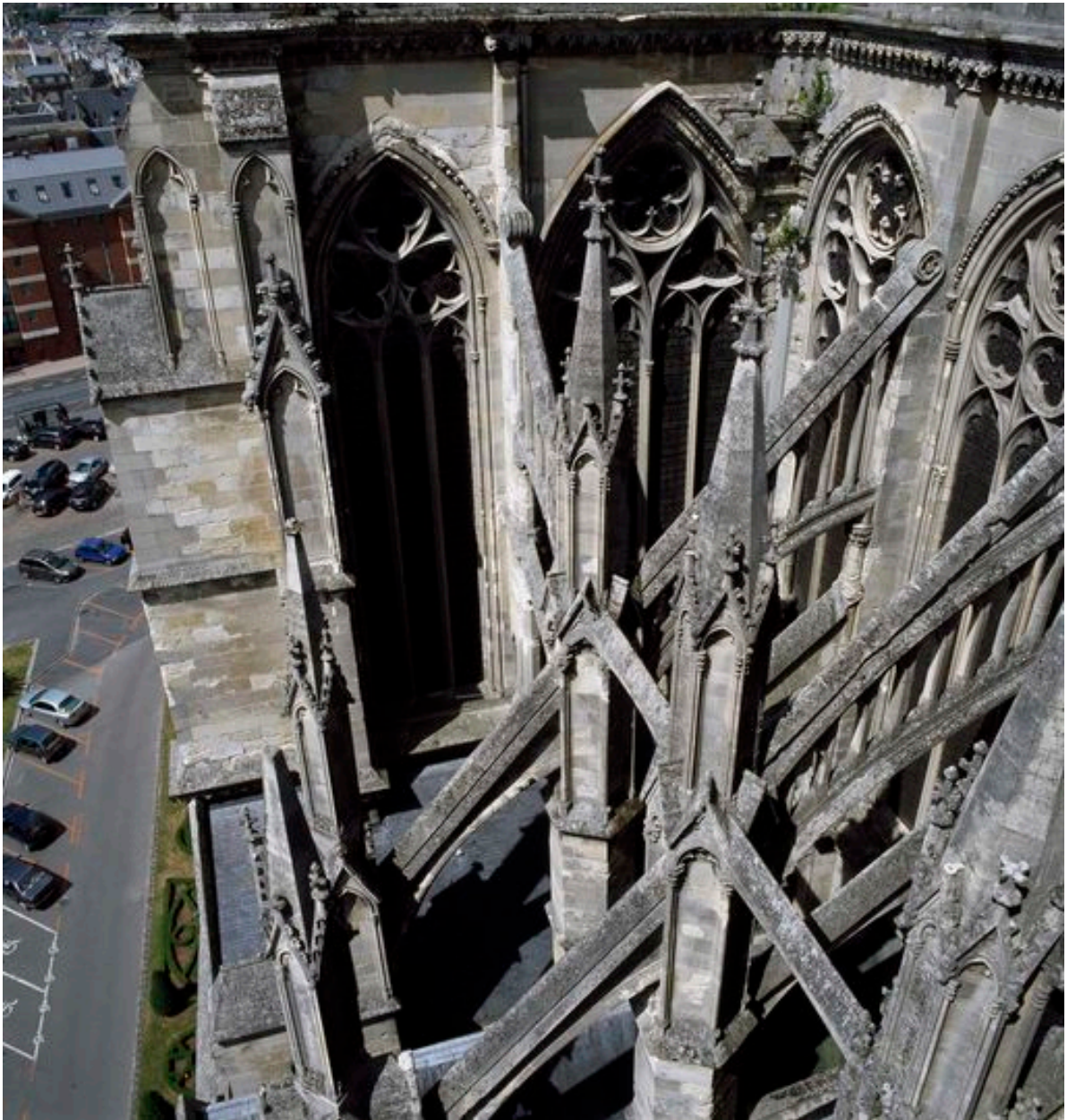
Vue du contrebutement au sud du chœur.
