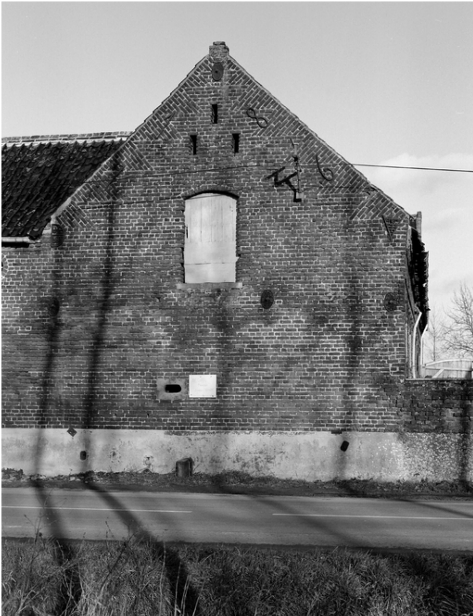
Le pignon des étables-écuries portant les fers d'ancrage patronymiques.
