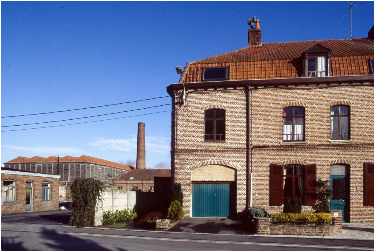
Vue générale depuis la rue. Logements de contremaîtres (bâtiment I) à droite et usine de blanchiment à gauche.
