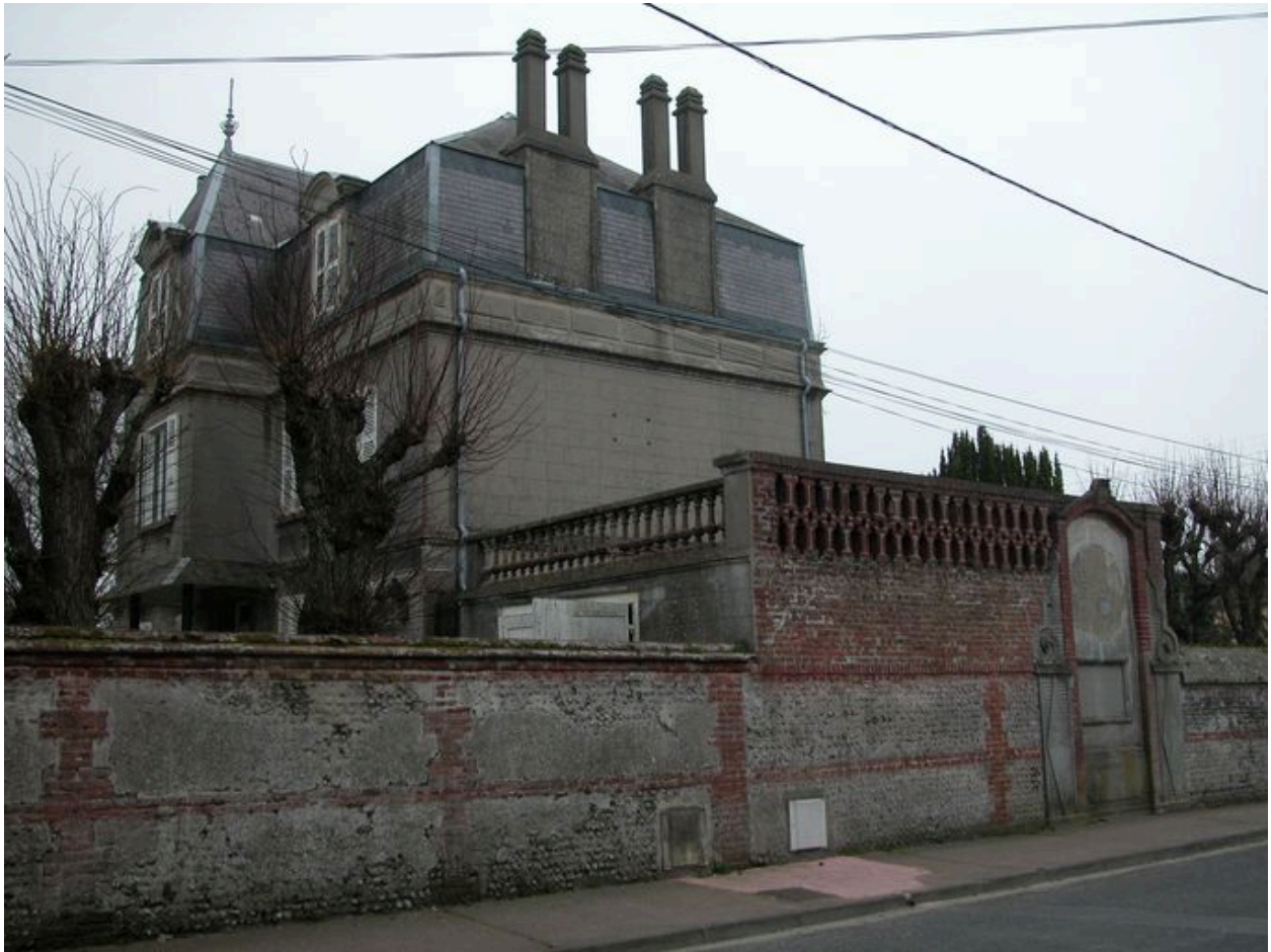
Vue de trois-quarts, élévations postérieure et latérale gauche.
