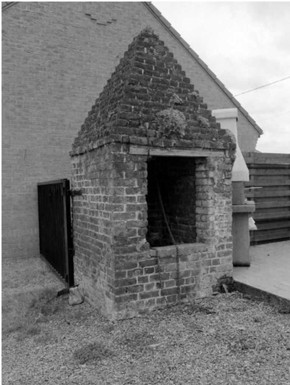
Vue générale du puits G.
