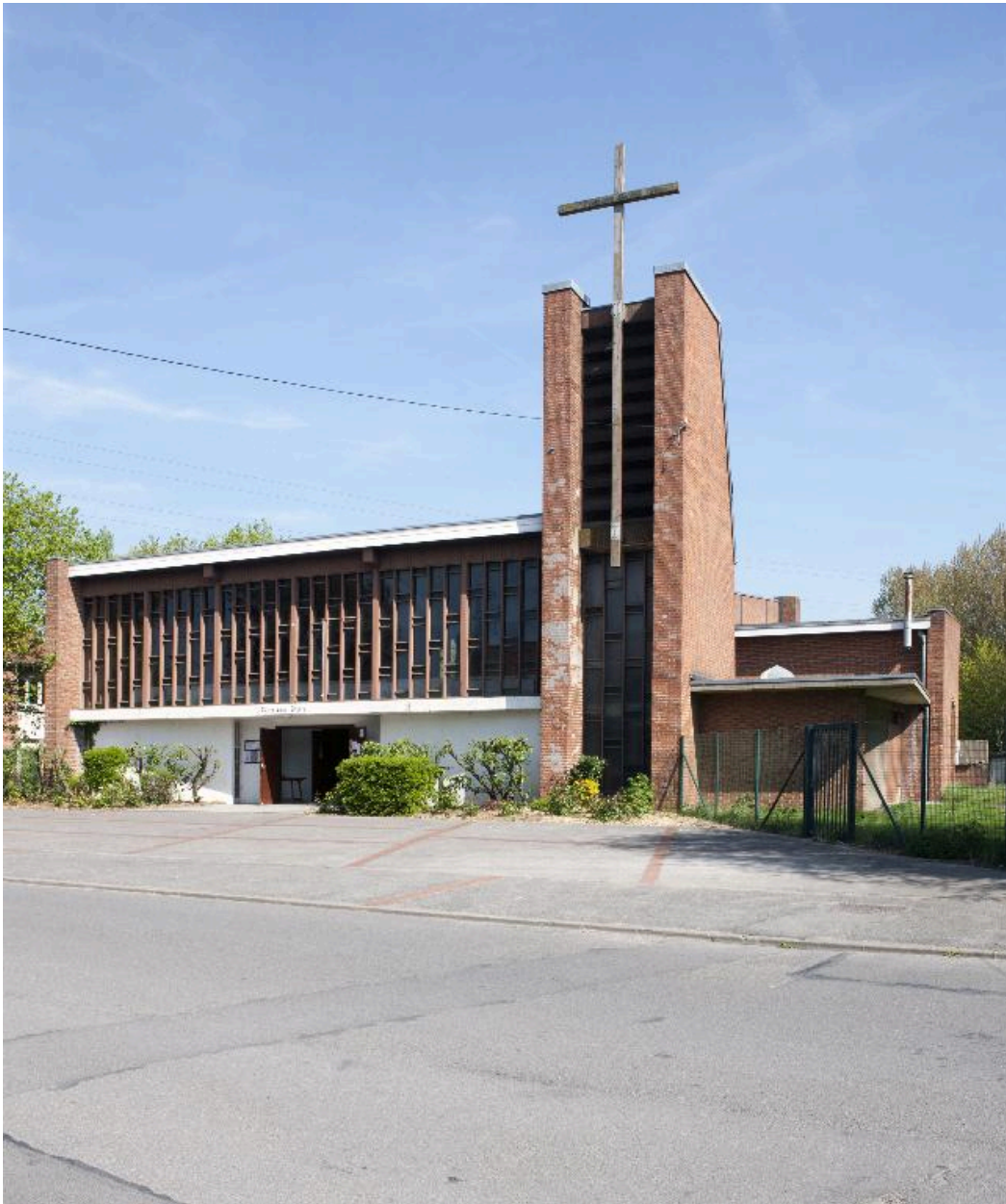
Vue de trois-quart de la façade antérieure.
