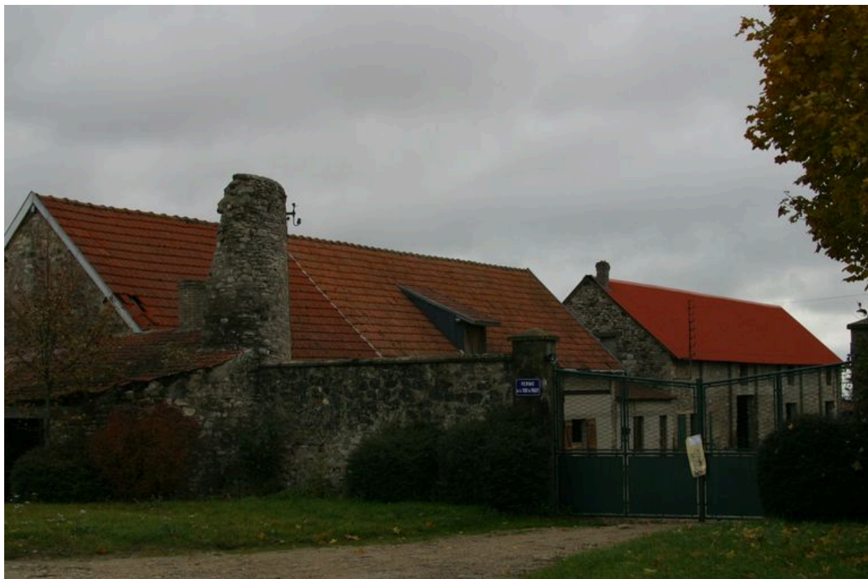
Vue générale des bâtiments agricoles.
