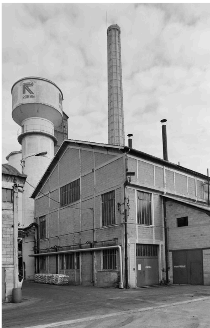
Chaufferie, château d'eau.
