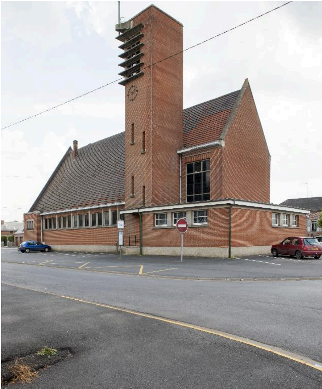
Vue de trois quarts droite de l'élévation postérieure.
