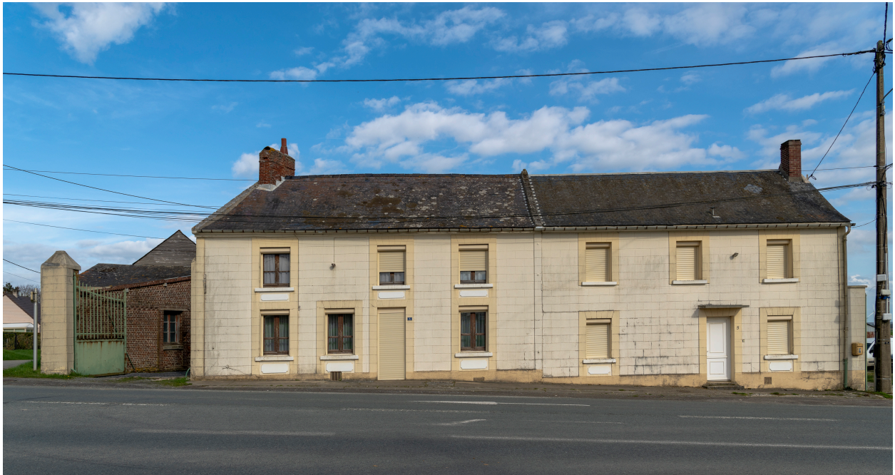
Hameau de La Folie : ancien relais et station essence, vue depuis l'ouest.
