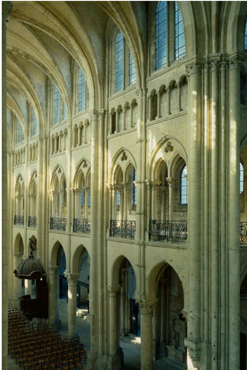
Vue intérieure de la nef, élévation nord.
