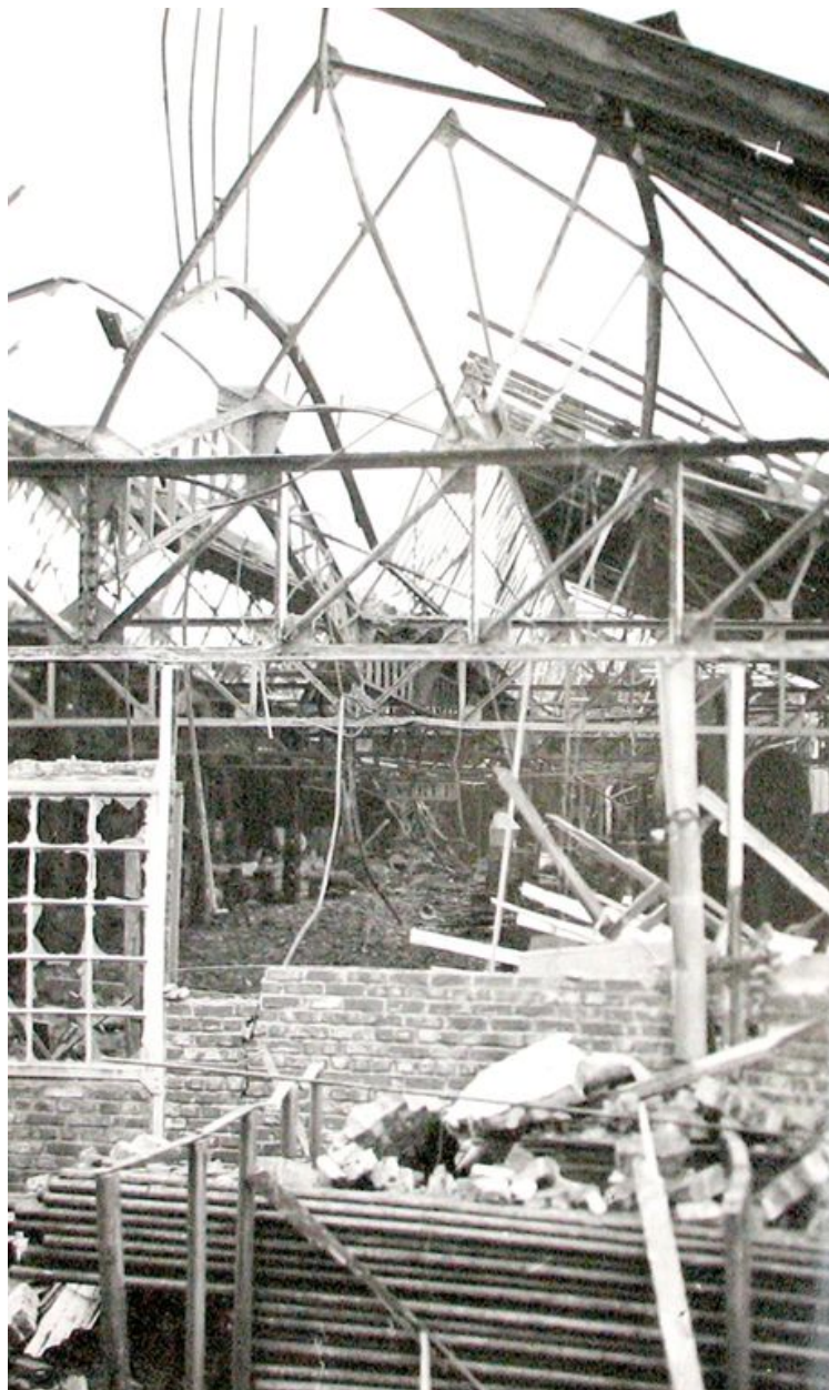
Bombardement du 23 mars 1944 : bombe n°11 tombée sur les forges et le bâtiment des presse, pignon ouest (AD Oise ; 753W28740).
