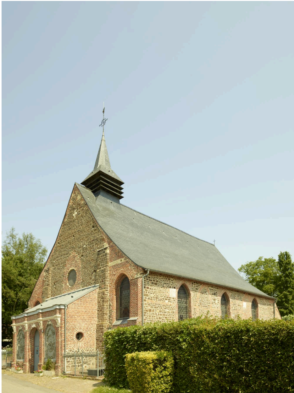
Façade et bas côté sud de l'église.
