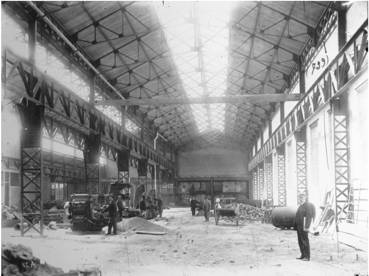
Les ateliers en cours de reconstruction, vers 1920-1921 (AD Aisne).
