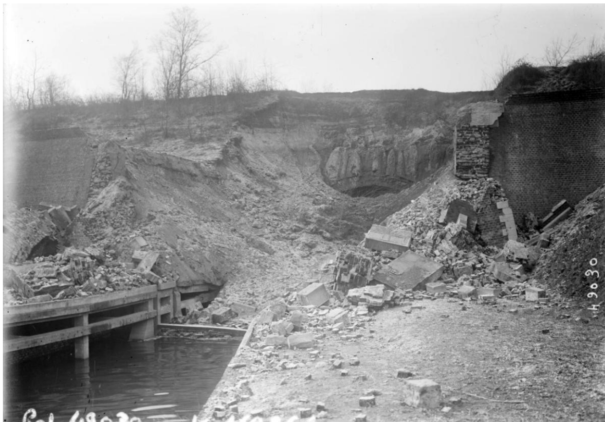
Tête nord du souterrain de la Panneterie minée. Photographie, 1917.
