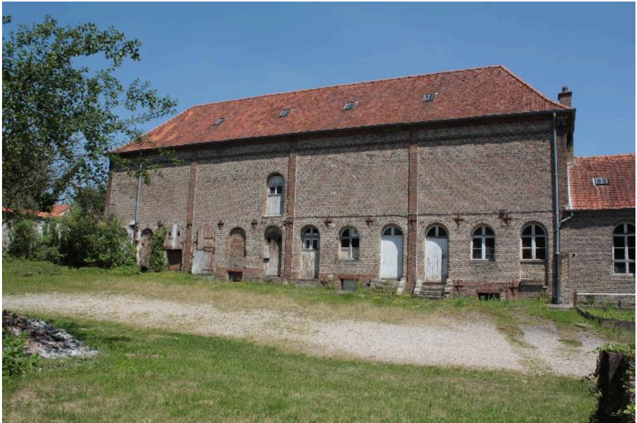
Façade sur cour de la laiterie, vue de face.
