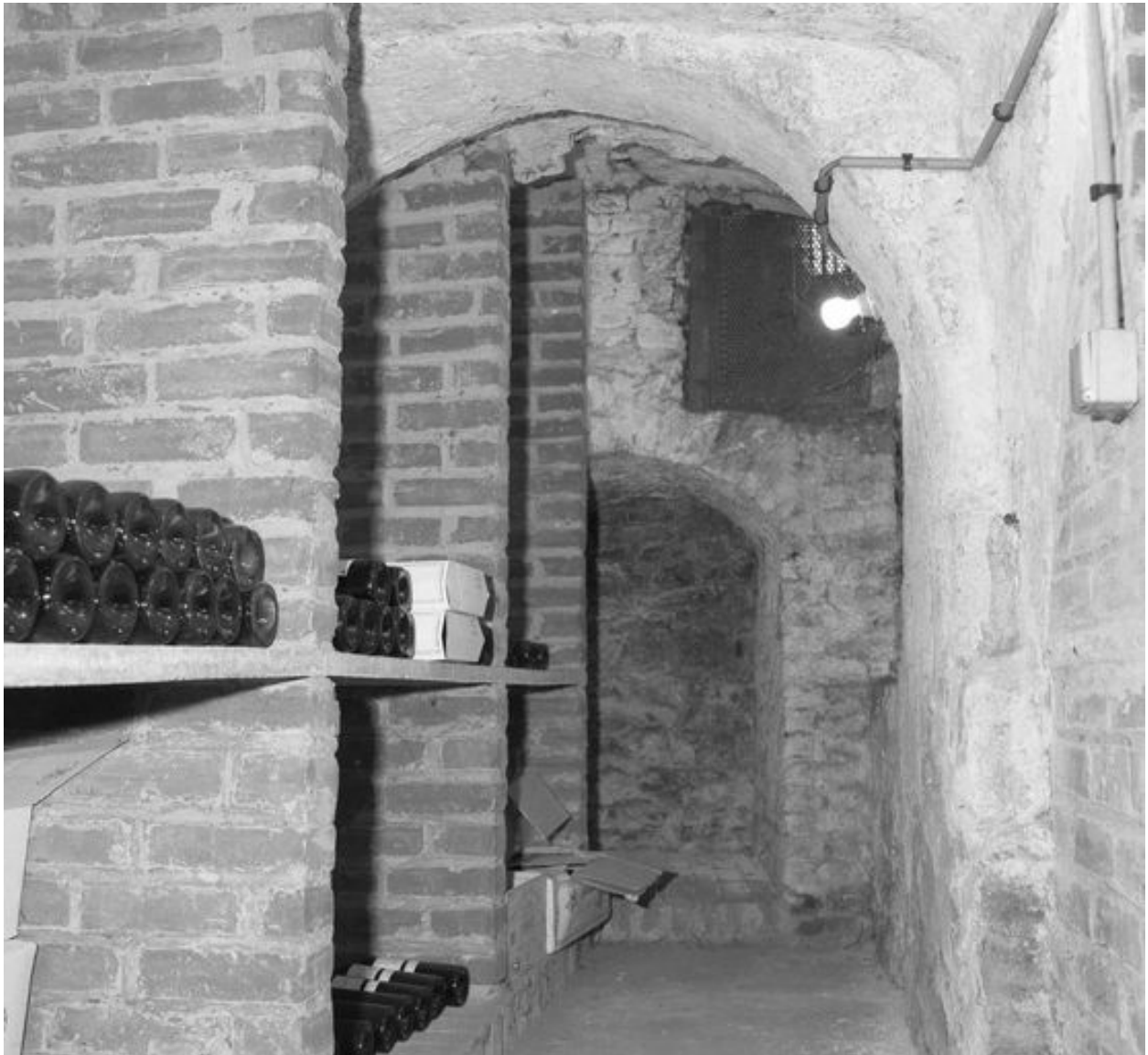
Sous-sol, vue partielle : de la cave médiévale vers l'extension postérieure.
