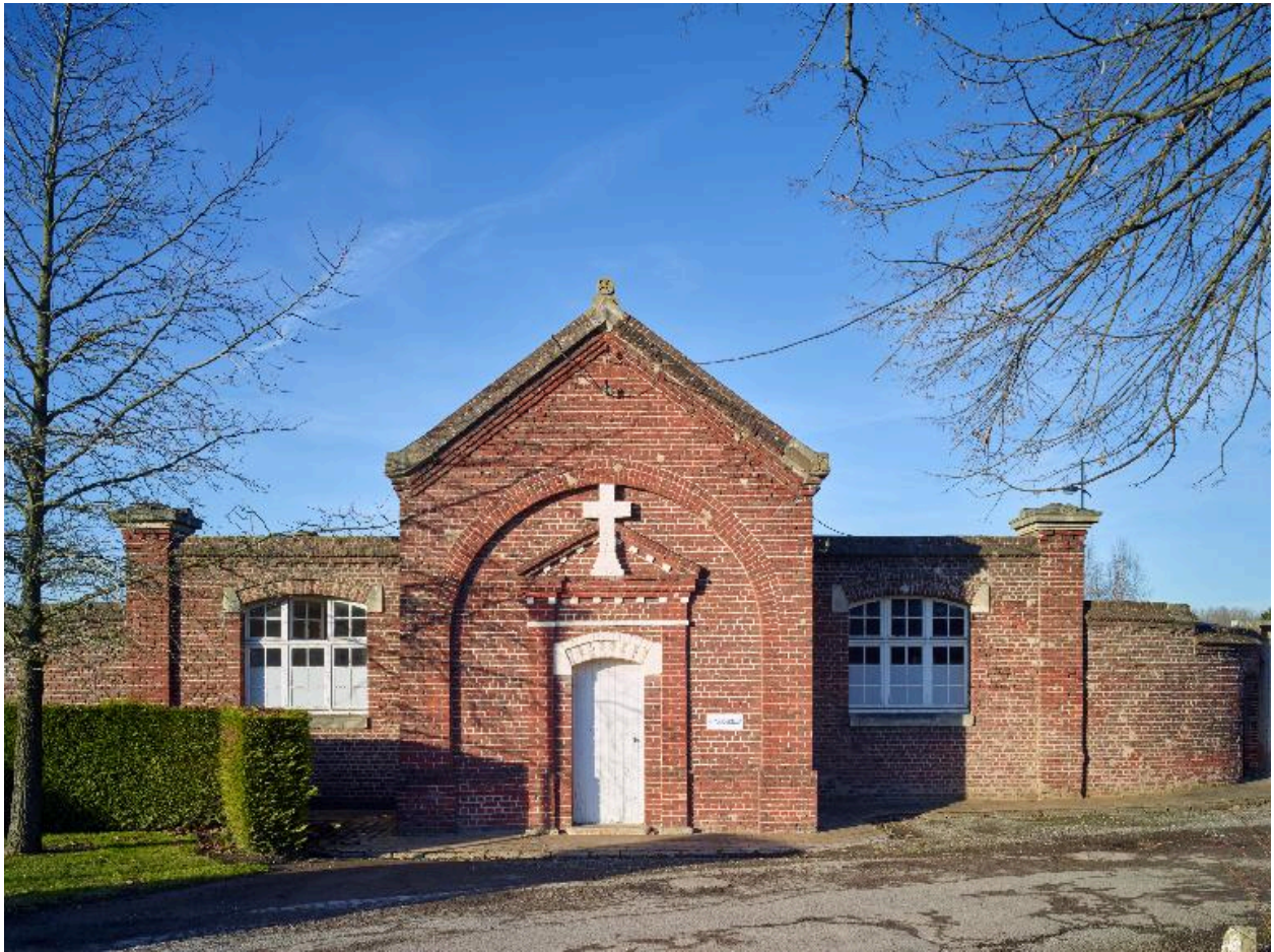
Morgue, façade antérieure, vue générale prise de face.
