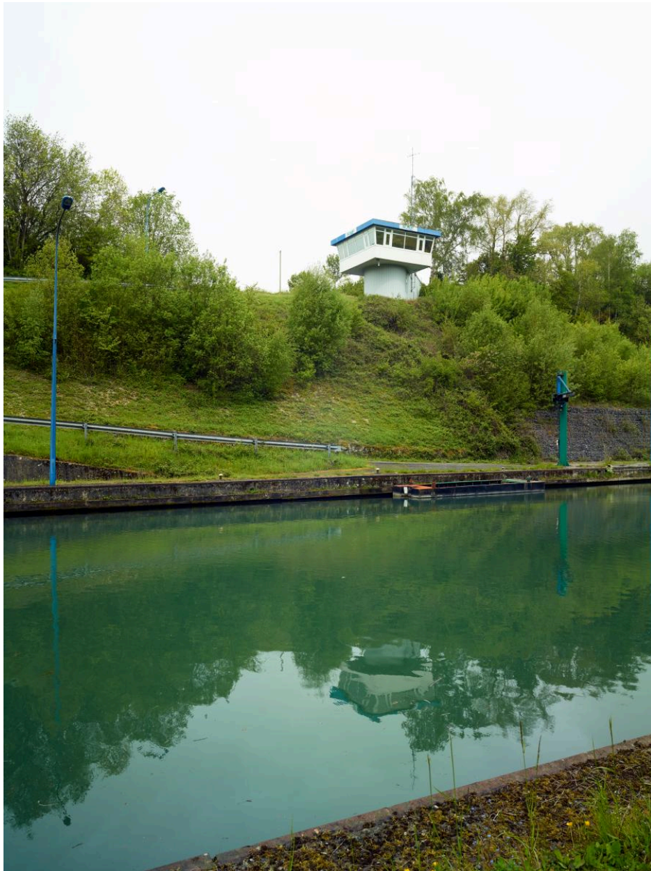
Vue depuis la tête nord, poste de commande, canal.
