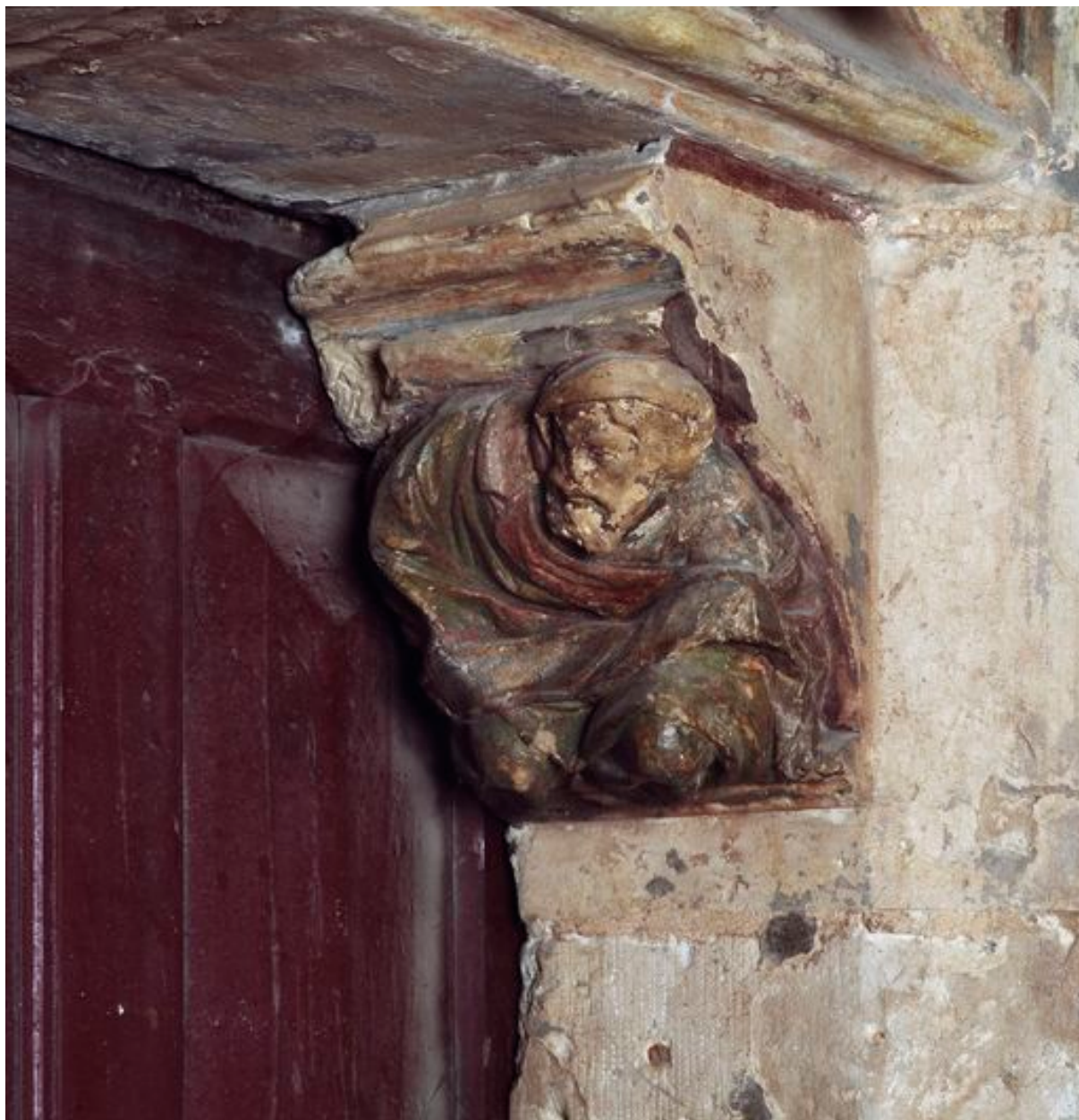
Décor du corbeau droit, après restauration.
