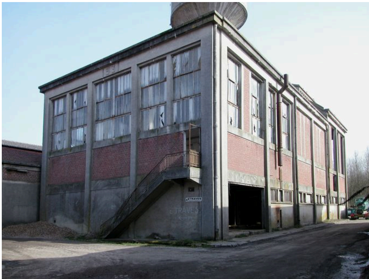
La chaufferie de 1931, vue d'ensemble.
